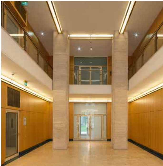
Abb. links: Insgesamt wurden in den öffentlichen Bereichen des Wohnturmes 100 laufende Meter an Messingprofileuchten verbaut. Hier im Foyer sind sie als Anbauversion ausgeführt.
